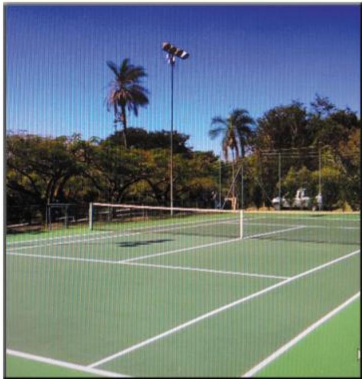
O revestimento de piso esportivo Durosport AC para quadras de tênis e poliesportivas é a base de resinas acrílicas e pigmentos inorgânicos, de alta resistência as intempéries e estabilidade de cor.
